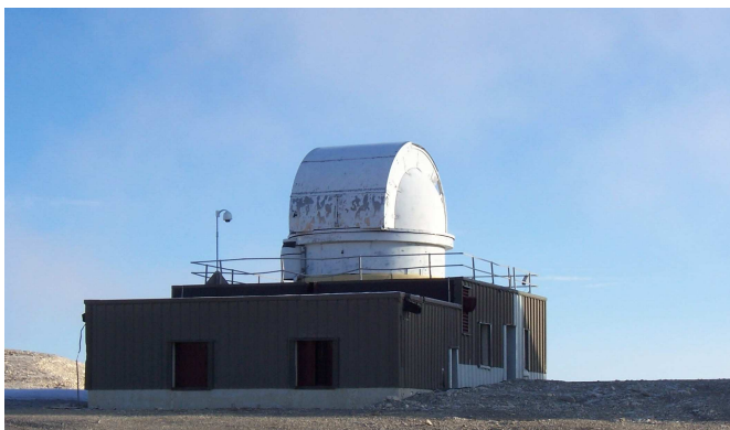
Bâtiment POM2 de l'Institut de radio-astronomie millimétrique (IRAM) abritant la plateforme ASTEP L2MP-STMicroelectronics. © L2MP-CNRS
